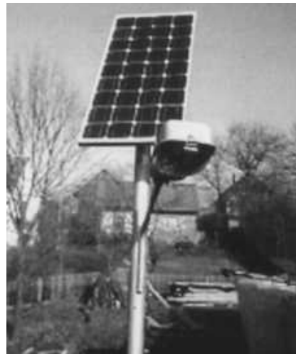
Рис. 5. Використання сонячної батареї для освітлення вулиці
