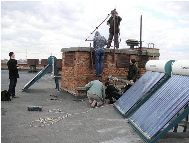
Рис. 1. Монтаж каркаса панелей солнечных батарей на крыше университета.
